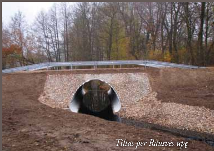
Iglės ež. slenksčio kapitalinis remontas
