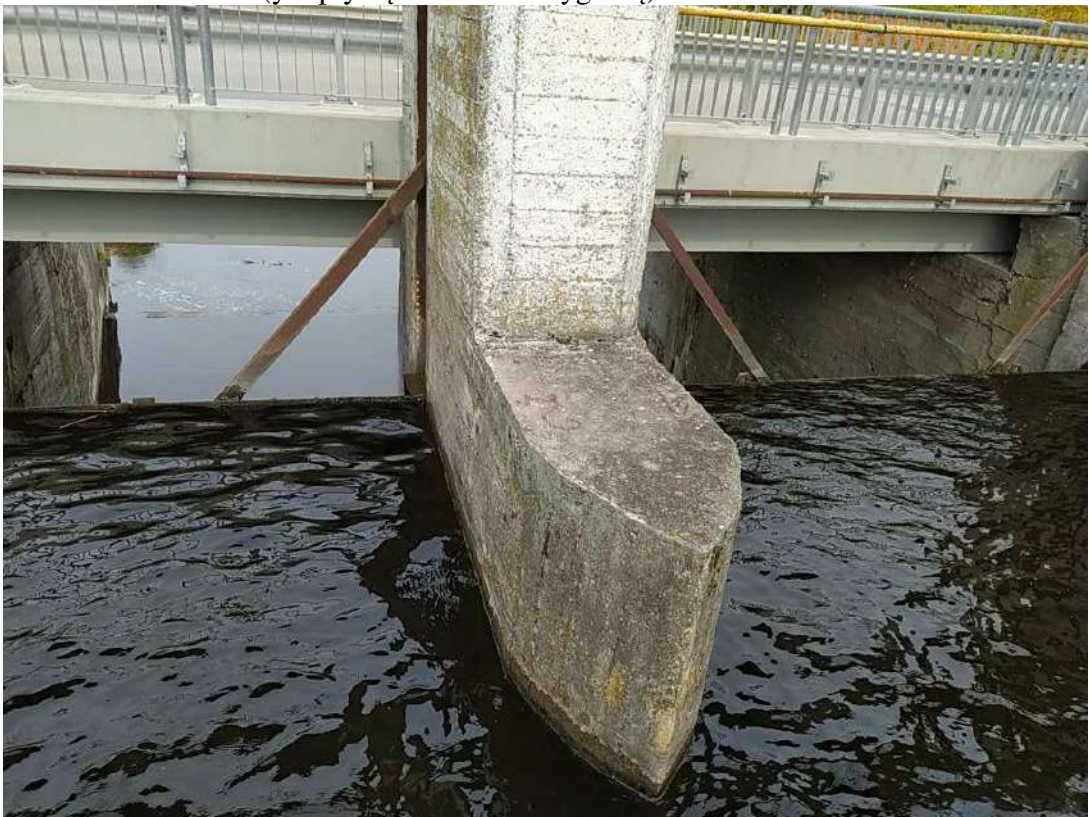
44 pav. Vidurinis tauras be žymesnių deformacijų ir pažeidimų.
