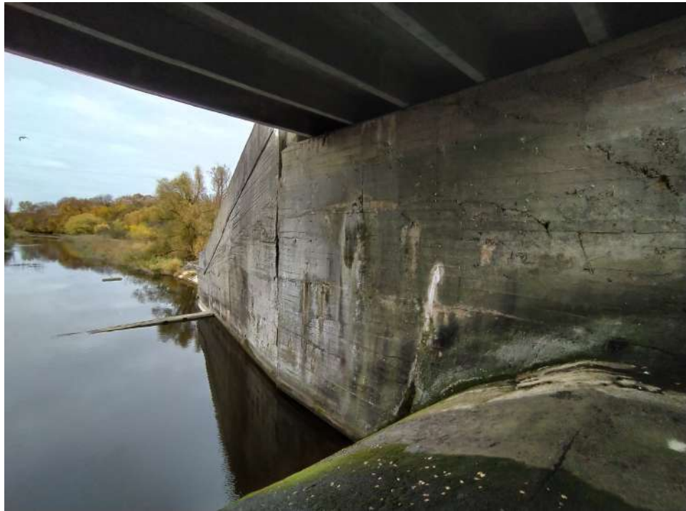
34 pav. Slenksčio – nuopylos viršuje, vandens nusilieimo zonoje pastebimi du, išilgai nuopylos išsidėstę iki 10 cm gylio ir 2-5 cm pločio betono plyšiai.
