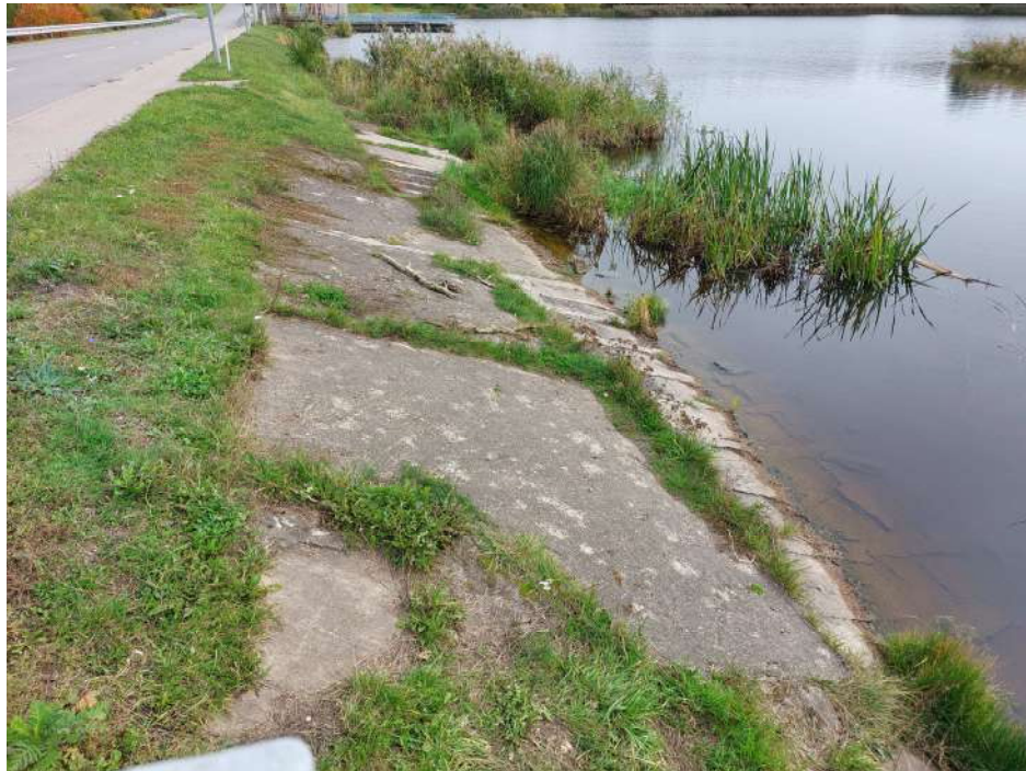
4 pav. Kairiojoje aukštutinio šlaito pusėje nuo įtekėjimo tvirtinimo plokštės vietomis užaugusios žolėmis, velėna, plokštės deformuotos, kai kurios sutrūkusios.
