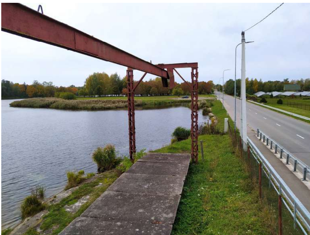
25 pav. Atsarginiai uždoriai sandėliuojami kairėje įtekėjimo pusėje esančioje kameroje uždengti GB plokštėmis.
