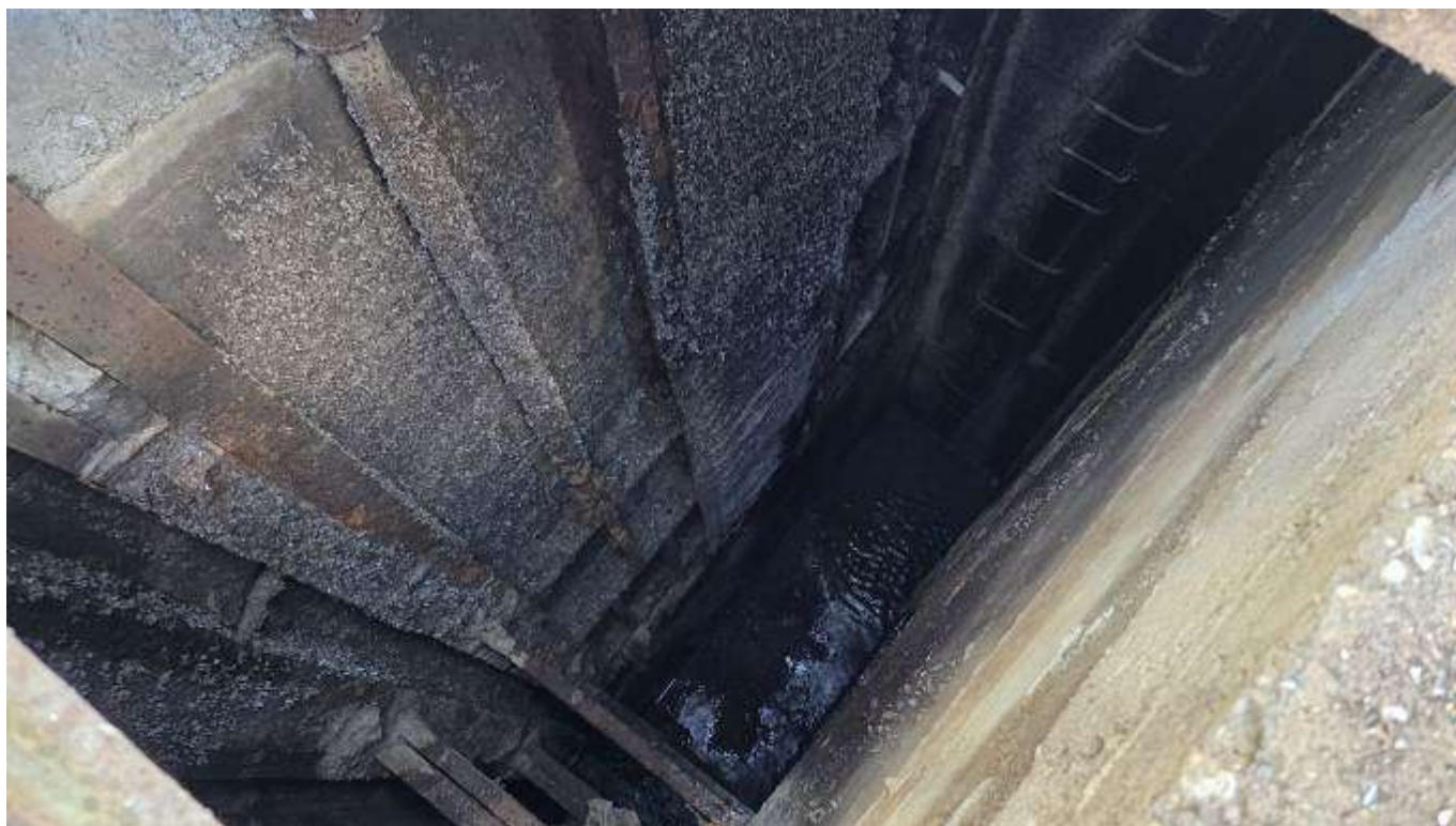
3.3. pav. Gamtosauginio vandens praleidimo kamera
