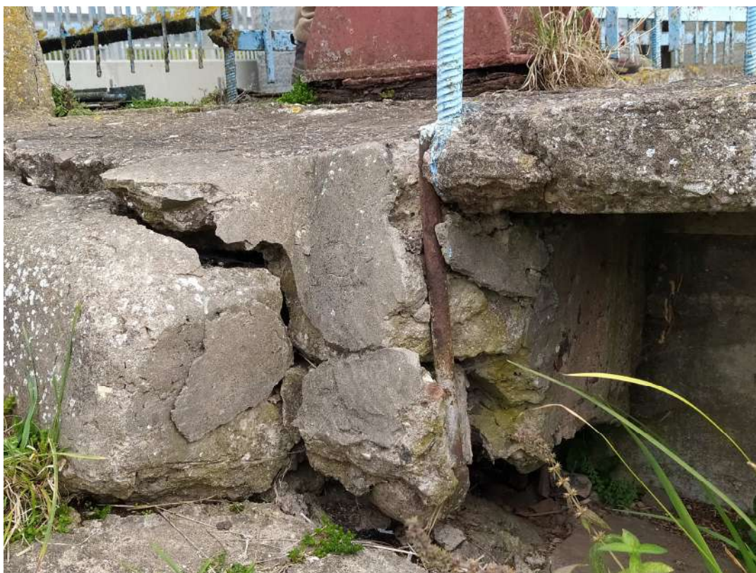
17 pav. Kairiojo sparno ir tauro sujungimo vietoje betonas visiškai sulūžęs ir sutrupėjęs.
