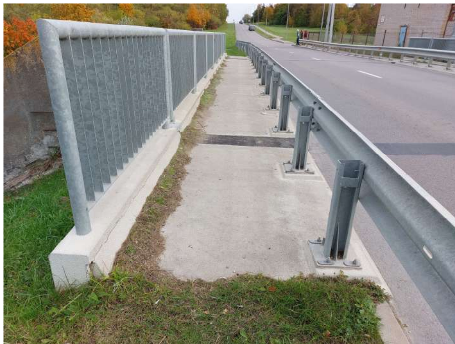
3 pav. Eismo saugumui užtikrinti abiejose tilto pusėse įrengti šalitilčiai ir kelio atitvarai.
