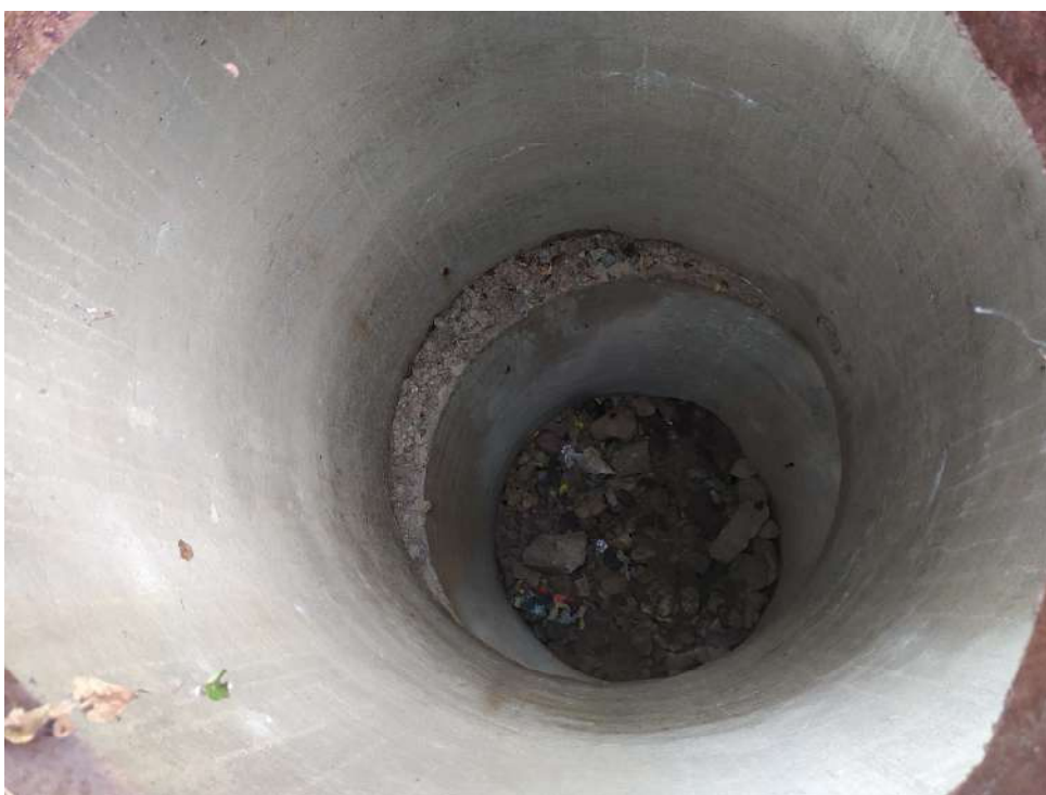
12 pav. Šulinio žiedai deformuoti, prasislinkę tarpusavy, dugne - šiukšlės ir sąnašos.
