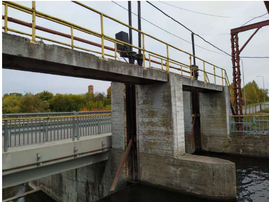
43 pav. Statinio rekonstravimo metu uždorių kilnojimui buvo įrengti 3 taurai. Taurų konstrukcijoje žymesnių deformacijų ir betono pažeidimų nenustatyta. Esamų vertikalių sienų ir naujai įrengtų taurų sujungimai išbetonuoti netinkamai (yra plyšių ir betono nelygumų)
