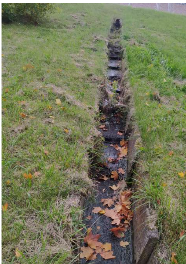
9 pav. Vandens nuleidimui nuo kelio dangos šlaite įrengtas latakas, jo elementai deformuoti, keletas sulaužyti, vanduo prasigraužęs pro latako apačią.
