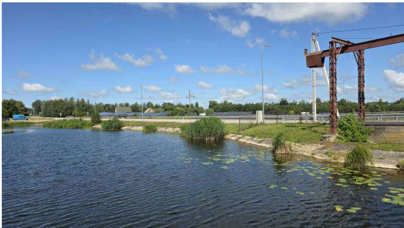
3.10. pav. Žemių užtvankos aukštutinis šlaitas
