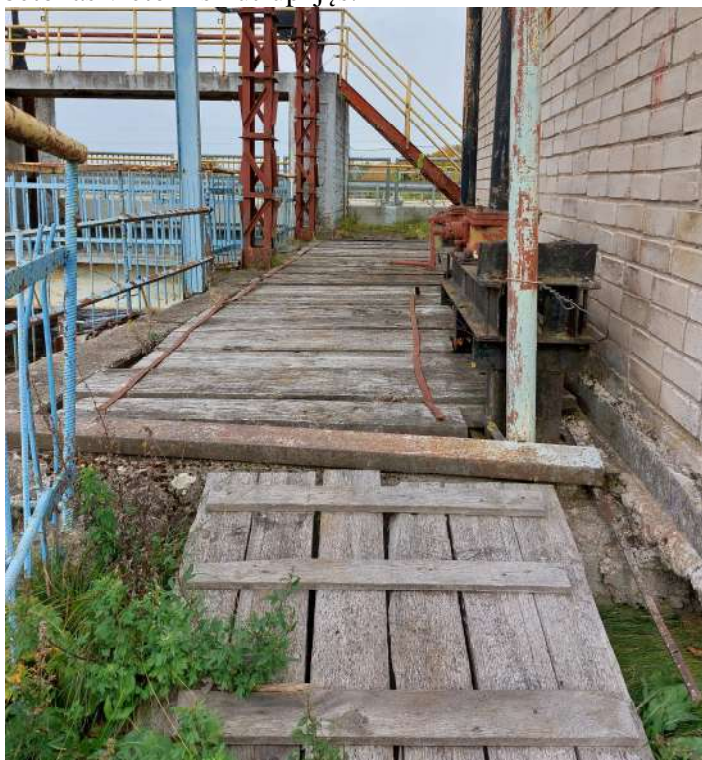
19 pav. Vandens įleidimo į siurblinę ir gamtosauginio debito praleidimo kamera uždengta medinėmis lentomis. Lentos sutrūnijusios, vietomis dideli plyšiai tarp lentų.
