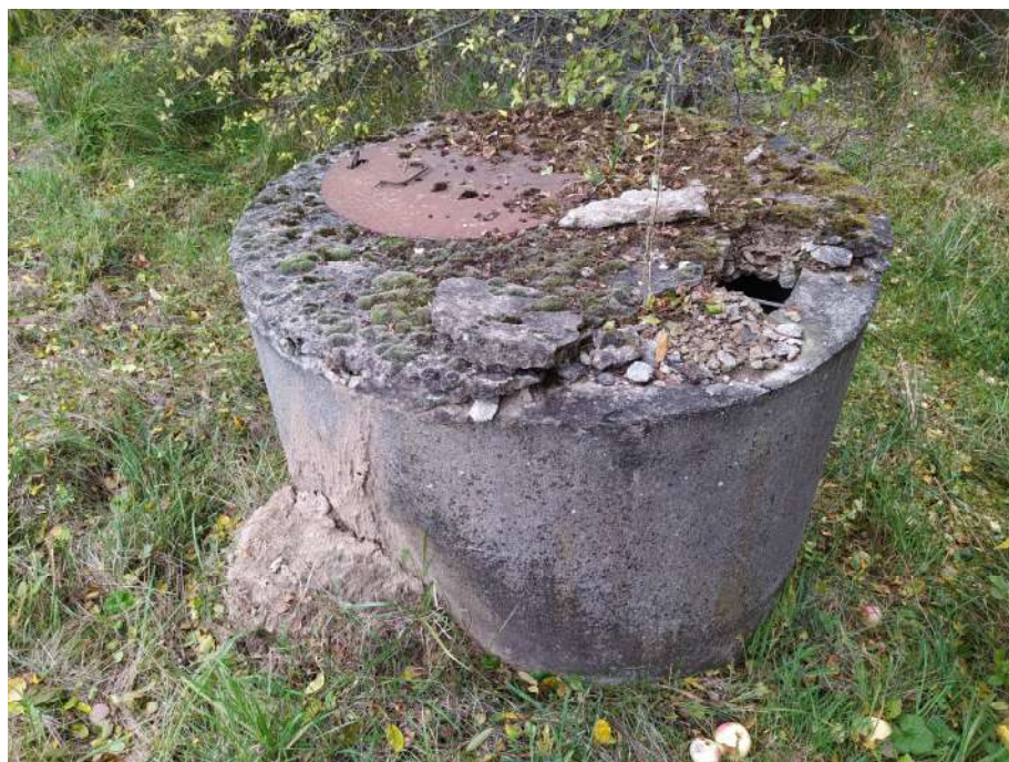
11 pav. Dešinėje užslenkstės pusėje esantis drenažo šulinys susidėvėjęs, dangčio betonai sutrupėjęs, nesandarus.
