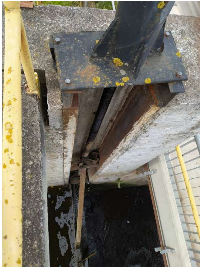
28 pav. Uždorių kilnojimui taurų viršuje įrengti keltuvai, pritvirtinti prie taurų metalinių detalių. Uždorių kilnojimo kolonėlės aprūdijusios, seniai dažytos, nežymiai deformuotos.
