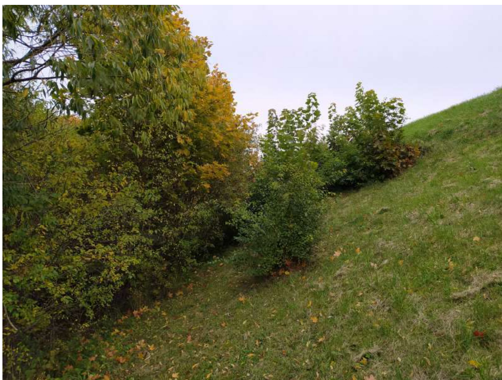
10 pav. Dalis užtvankos šlaito ties latakų ir drenažo linija yra apaugęs krūmais.
