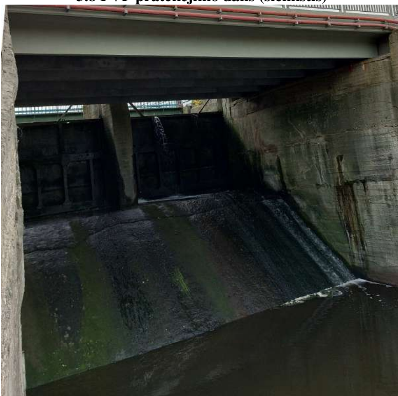
31 pav. PVP pratekėjimo dalis - praktinio profilio GB nuopyla su atraminėmis sienomis (ramtais) ant kurių laikosi tilto konstrukcija. Betono paviršiai paveikti abrazijos, sušiurkštėję nuo vandens tėkmės ir čiurkšlių poveikio. Nusėdimo ar pakrypimo požymių nėra.
