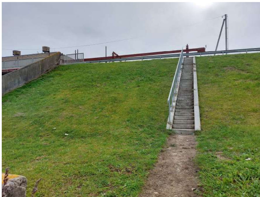
7 pav. Žemutinis šlaitas be didesnių deformacijų, yra keletas smulkių nelygumų. Kairėje užslenkstės pusėje šlaite įrengti nauji laiptai.
