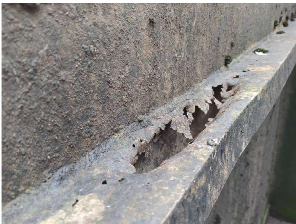
22 pav. Prarūdijusios uždorių sustiprinimo metalinės dalys.
