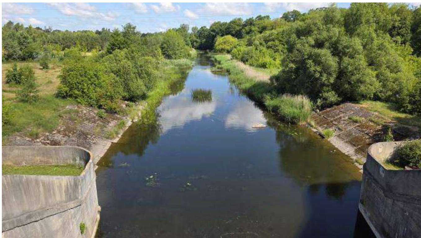
3.9. pav. Risberma ir galinis tvirtinimas
