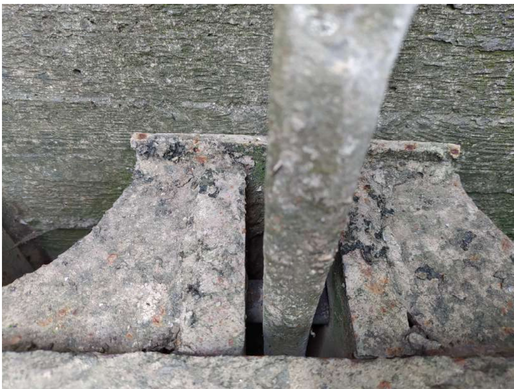
24 pv. Uždorio pakėlimo mechanizmas (kaištis) yra per plonas, HTS prižiūrėtojo teigimu kai kada keliant skydus nutrūksta.
