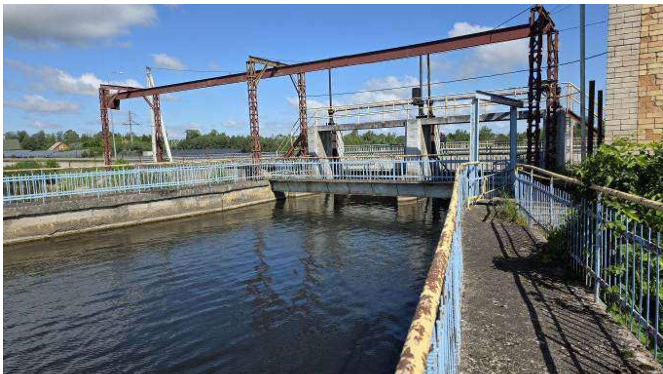
3.4. pav. VPP įtekėjimo dalis
