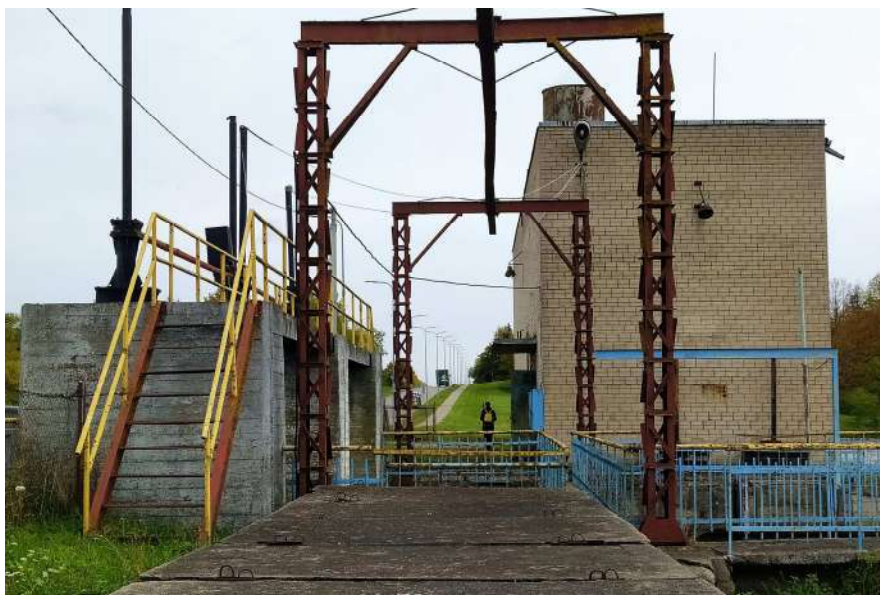
30 pav. Atsarginių uždorių-skydų iškėlimui ir pastatymui įrengtas keltuvas su sija ant metalinių atramų konstrukcijos Kėlimo mechanizmas nuimtas, talpinamas atskirai, Atramos ir sija nežymiai deformuotos, su vietomis nusilupusiu dažų sluoksniu. Atramos suvirintos iš smulkių metalo konstrukcijų, neturi estetiško vaizdo.
