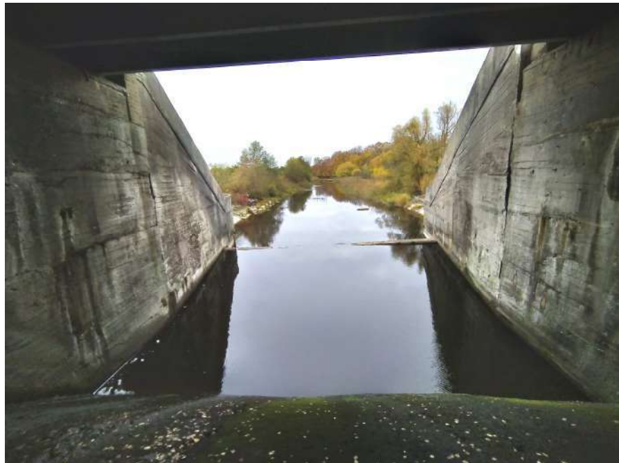
35 pav. PVP ištekėjimo dalis (užslenkstė) yra stačiakampio formos platėjantis lovys, pagal užtvankos šlaitą žemėjančiomis sienomis, kurių viršuje įrengta g/b tvorelė. Ties sujungimu su galiniu tvirtinimu, abiejose pusėse užslenkštės sienos sparnai išlenkti ir nukreipti lygiagrečiai užtvankai.
