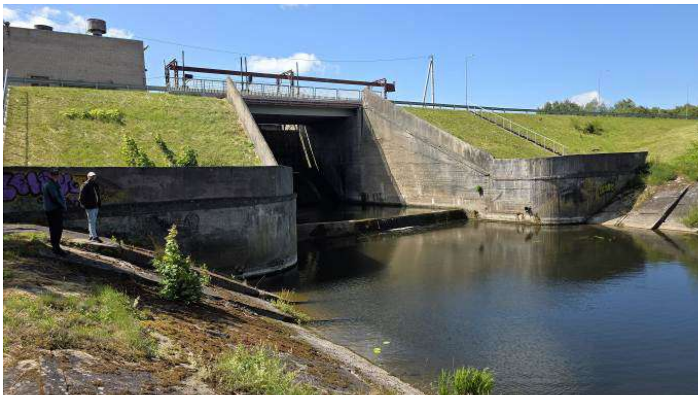
3.8. pav. VPP ištekekājimo dalis
