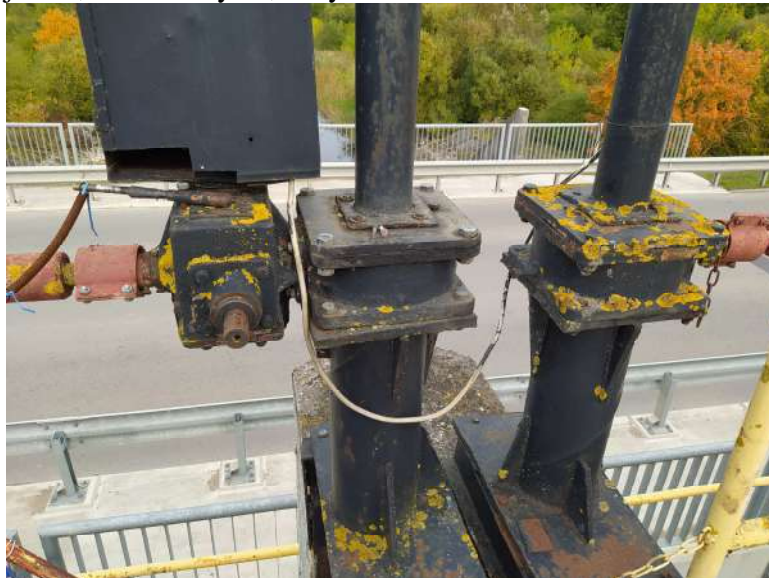
28 pav. Uždorių kilnojimui taurų viršuje įrengti keltuvai, pritvirtinti prie taurų metalinių detalių. Uždorių kilnojimo kolonėlės aprūdijusios, seniai dažytos, nežymiai deformuotos.
