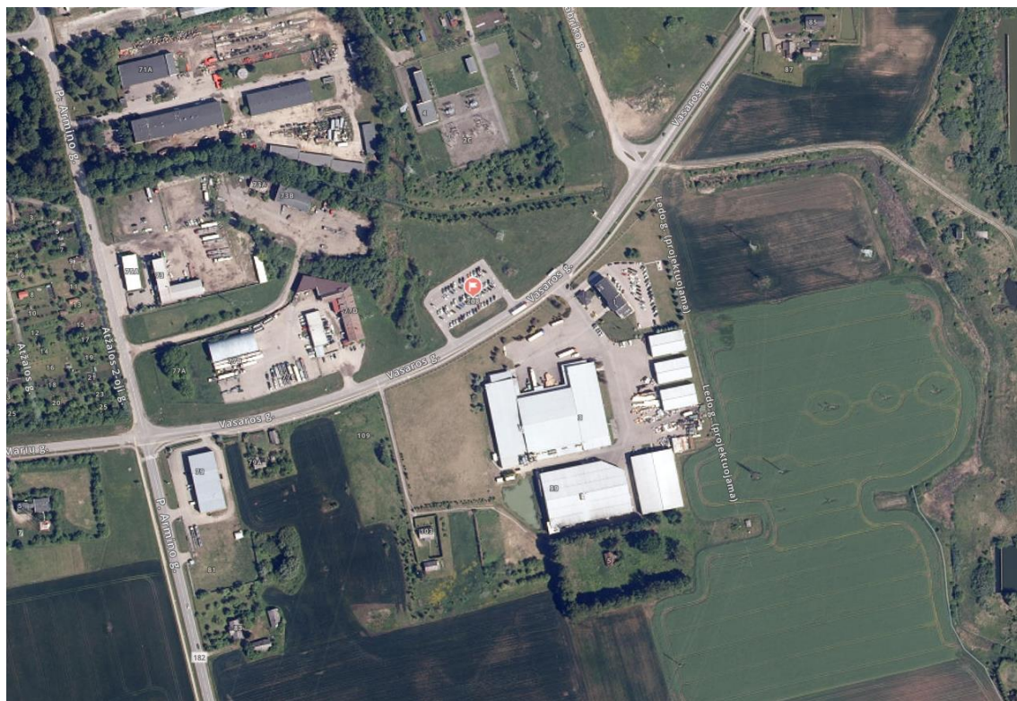
3 pav. Bendra vietovės schemos ortofoto nuotrauka (raudonas taškas rodo esamą aikštelę, šalia kurios iš dešinės pusės projektuojama aikštelė)
