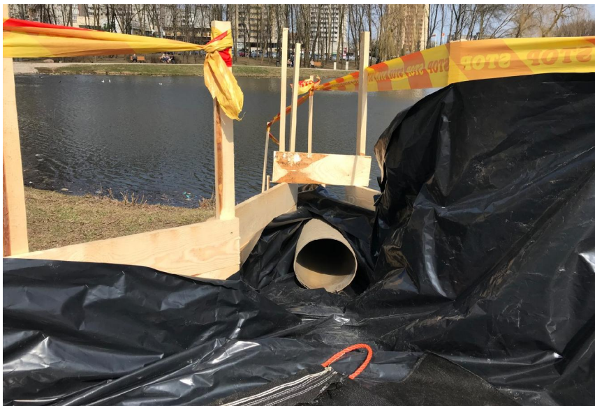
7 pav. Dumblo sausinimo (nuvandeninimo) maišo aikštelės pagrindas išklojamas nepralaidžia danga.
