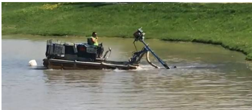
8 pav. Dugno nuosėdų (dumblo) siurbimas žemsiurbės pagalba.
