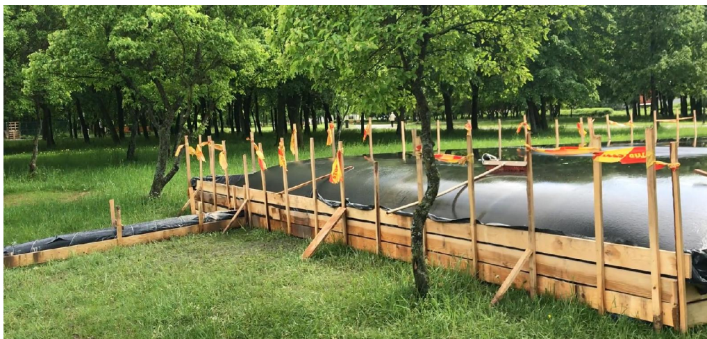
9 pav. Dumblo sausinimo (nuvandėninimo) maišas su apsauginėmis sienelėmis ir filtrato nuvedimu į vandens telkinį.
