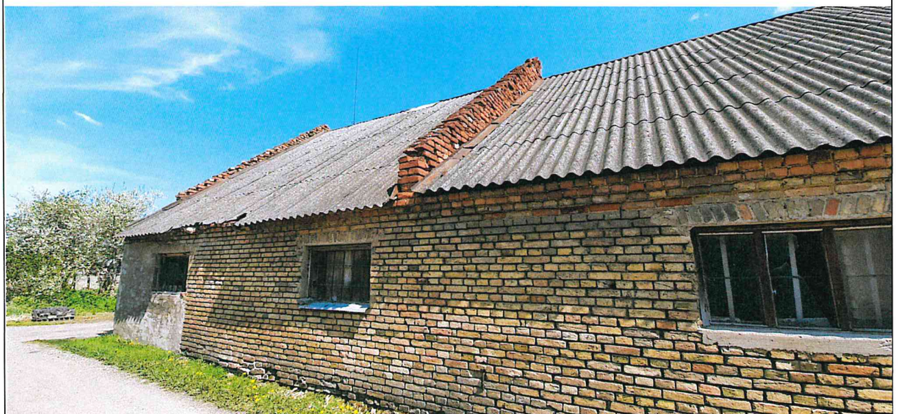
6. Pavadinimas: V pusės plytų mūro ugniasienė Fotografavo: Jūratė Leškevičienė
