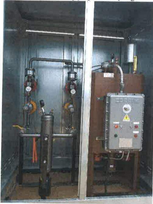
Suskystintų naftos dujų ūkis, statybos metu, prie naujai statomos katilinės
