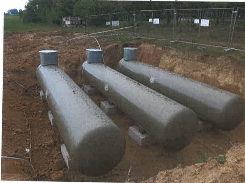
Suskystintų naftos dujų ūkis, statybos metu, prie naujai statomos katilinės
