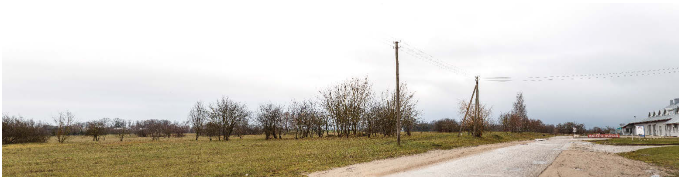
1 pav. Esamos situacijos fotofiksacija
